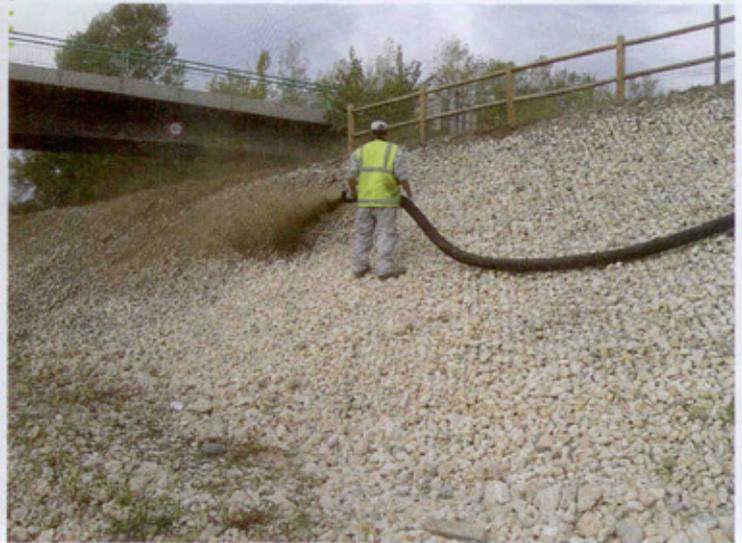
• Mise en place de la couverture anti-érosion Euro Mat BFM à l'aide d'un hydroseeder.
