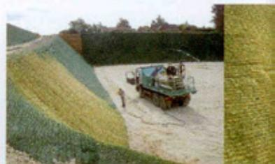
Détail de la mise en œuvre de la membrane anti-érosion Euro-Mat sur géogrille 3D.
