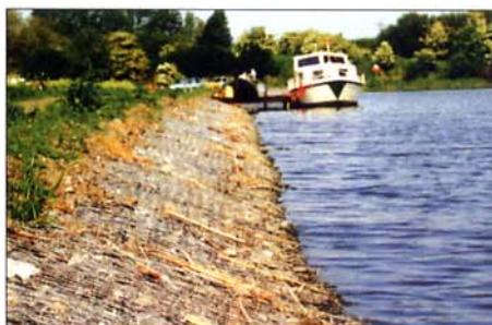
Protection de berge par gabions matelas.
