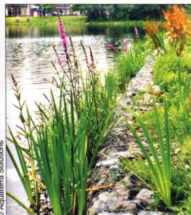
Association de gabions et de techniques végétales pour la végétalisation de berge.
