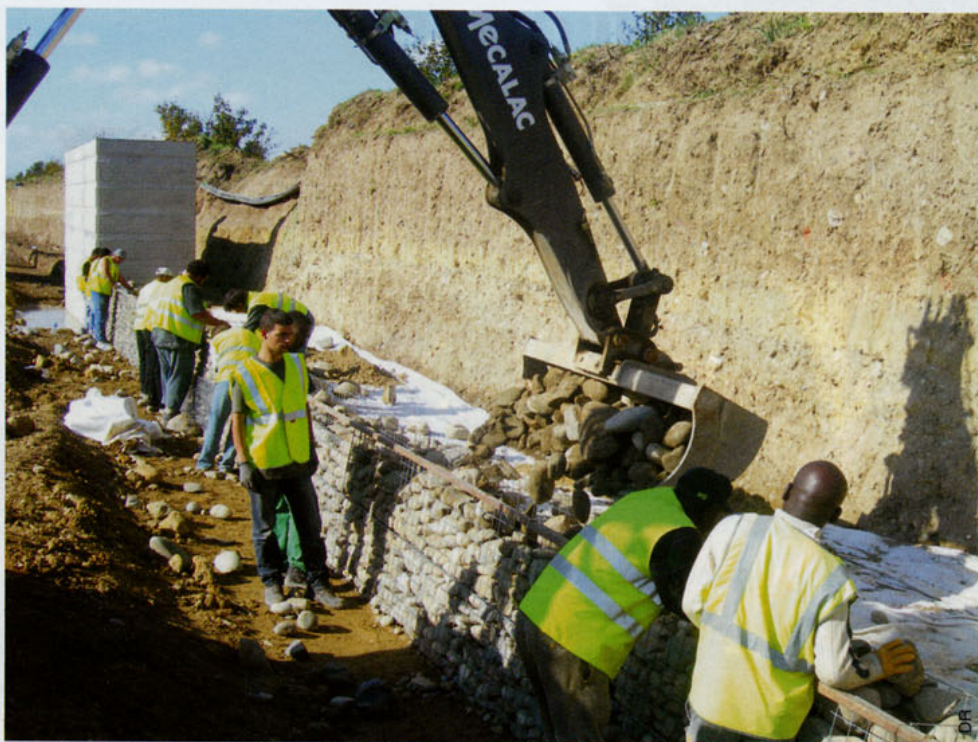
Remplissage des cellules avec les galets ou les concassés.
