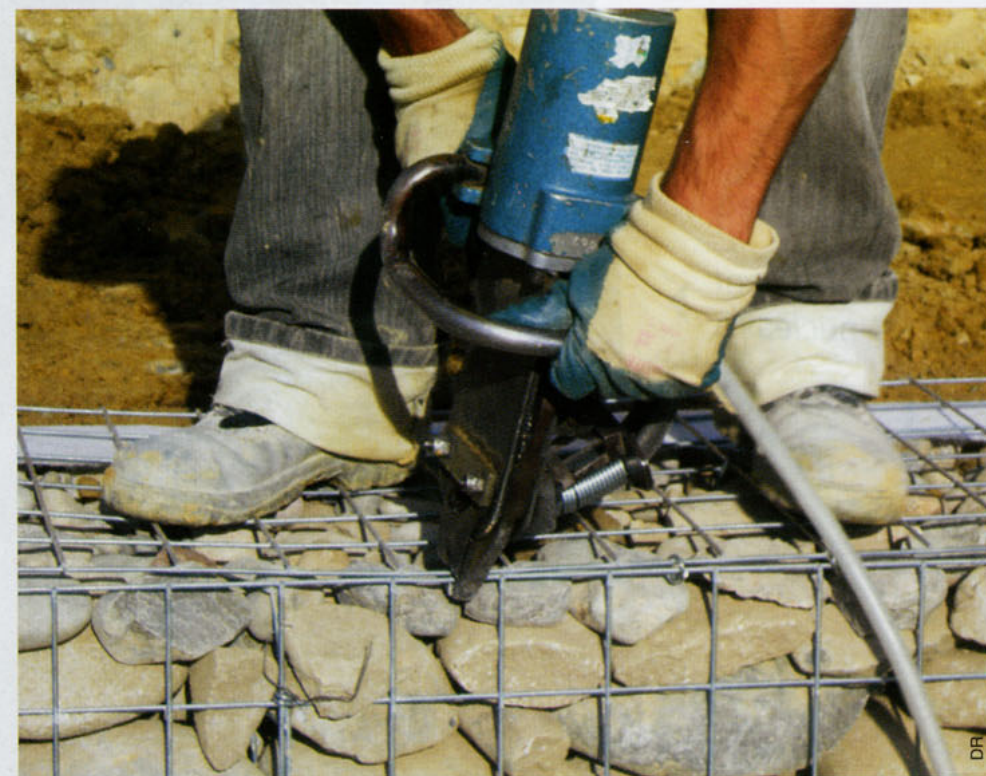
Fixation des fils métalliques grâce à une agrafeuse pneumatique, chaque agrafe étant distante d'une dizaine de centimètres de la précédente.
