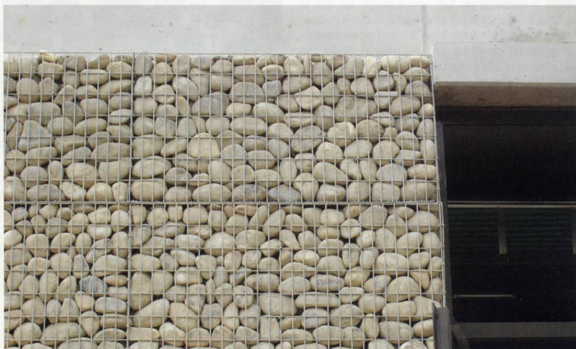
La hauteur maximale de 70 cm permet, de l'extérieur, le remplissage soigné des pierres du parement avec un appareillage manuel.
