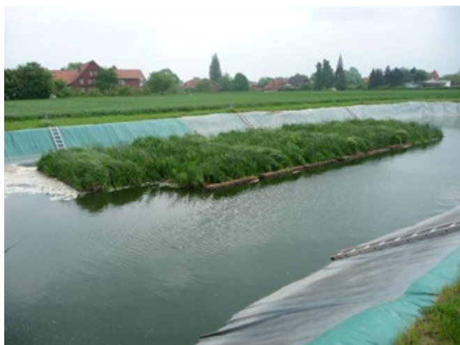
Radeaux végétalisés avec des nattes de Xylit végétalisées d'hélophytes entourés par des boudins (fascines) de Xylit.
