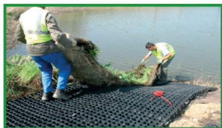
Bâtir les radeaux au bord de l'eau. Dérouler et étirer les géonattes coco pré-végétalisées. Les mettre bord à bord et les attacher entre elles.
