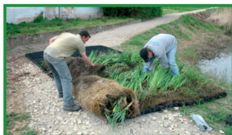
Bâtir les radeaux au bord de l'eau. Dérouler et étirer les géonattes coco pré-végétalisées. Les mettre bord à bord et les attacher entre elles.
