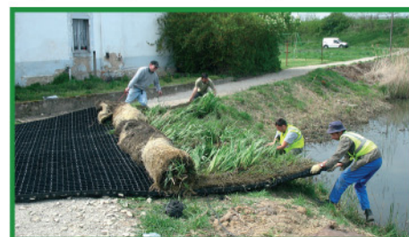
Bâtir les radeaux au bord de l'eau. Dérouler et étirer les géonattes coco pré-végétalisées. Les mettre bord à bord et les attacher entre elles.
